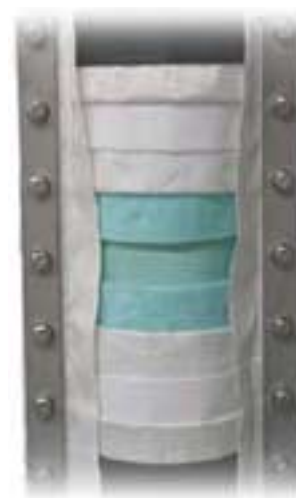
Laagopbouw van de compensatoren
